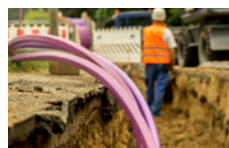
12 bar: perforazioni e posa cavi
