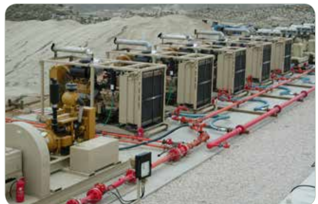
Servicios de canalización
